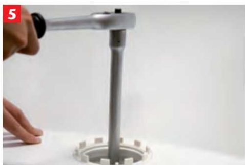
Beim Einschrauben der Rückstaeinheit auf den korrekten Sitz des Gewindes achten. Handfest anziehen.
