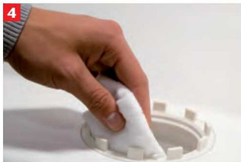
Innengewinde des Grundkörpers von Verschmutzung befreien. Nun können alle gesäuberten Elemente des Rückstauverschlusses wieder zusammengefügt werden
