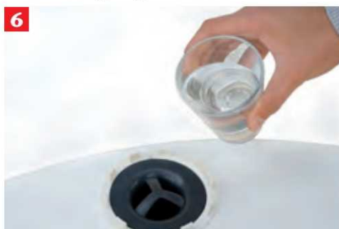
Anschließend den Geruchsverschluss in den Befestigungsring drücken und mit Wasser füllen. Danach den Laubfangkorb aufstecken und arretieren
