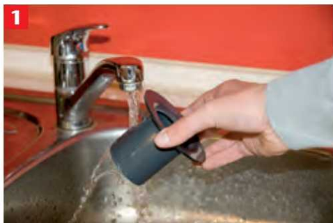
Den Geruchsverschluss unter Wasser säubern
